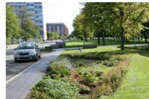
Princip for afledning af regnvand langs Kirkebjerg Parkvej 1:200
