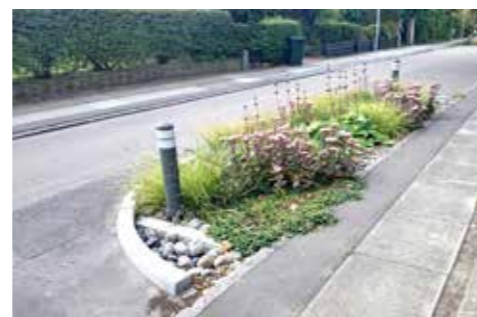
Princip for afledning af regnvand langs Kirkebjerg Parkvej 1:200
