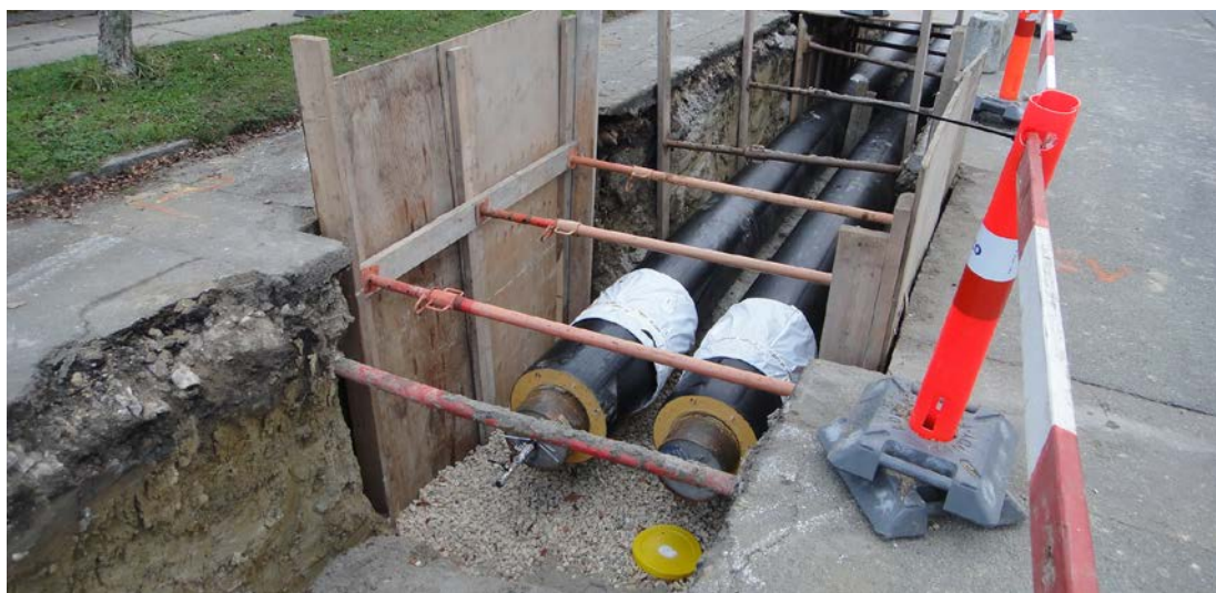
Figur 10: Billede fra Ragnesminde fjernvarmeprojekt i Brøndby (Grontmij A/S)
