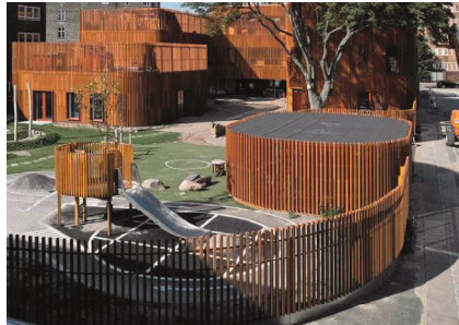
Eksempel på lette facader omkring fx et cykelskur, der fortsættes som læ-afskærmning.
